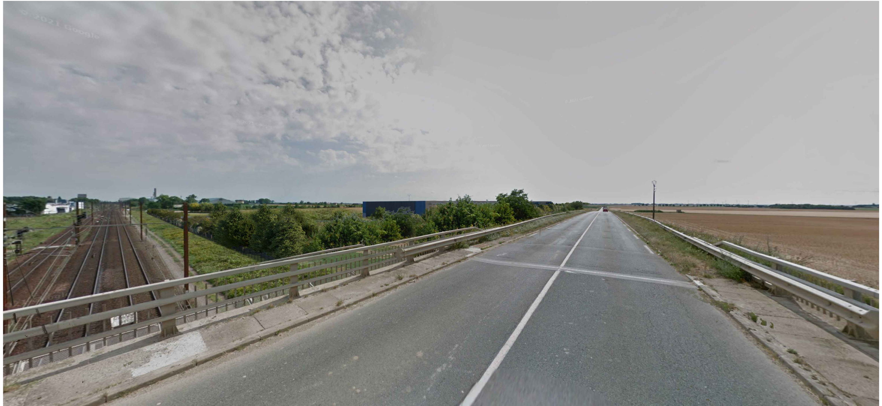
2 - INSERTION DANS L'ENVIRONNEMENT (VUE DEPUIS LE PONT)
