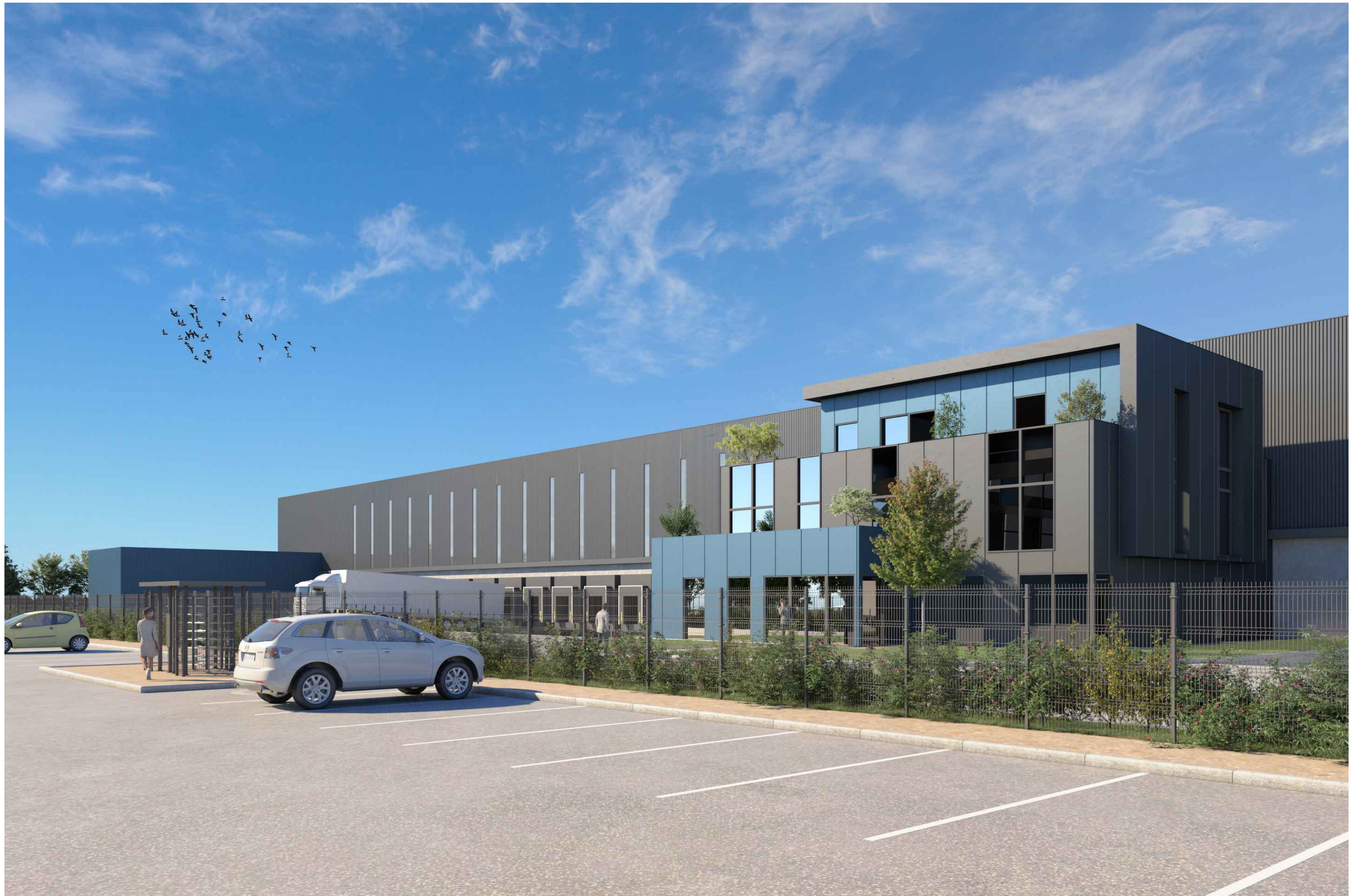
3 - VUE DES BUREAUX
